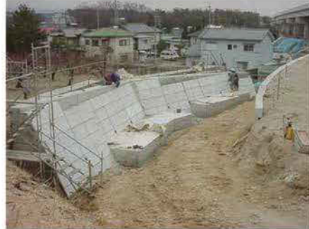
名四国道事務所 東海環状藤岡地区
