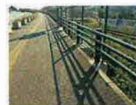
補修した後の全景
