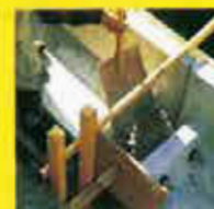
コンクリート打設状況
