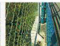
補修した近景
