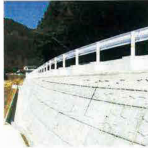
大型ブロック積擁壁
