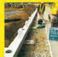
埋戻し、路盤工施工
