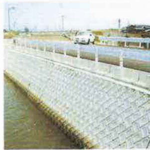
間知ブロック積擁壁
