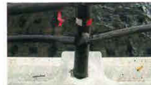
横断方から見た状況
