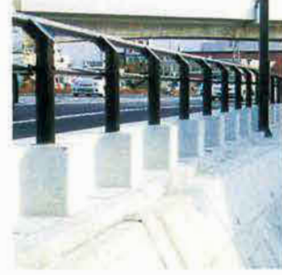
大型ブロック積擁壁
