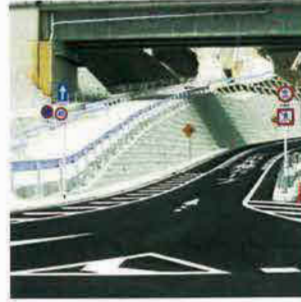
間知ブロック積擁壁
