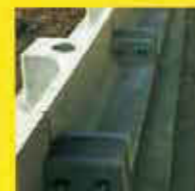
間詰めコンクリート完了
