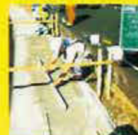
敷きモルタル
