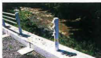
① ガードパイプを取り外した状況
