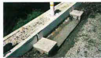
③ 底版上の土を取り除いた状況
