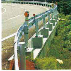
L型擁壁 (天幅前面に合わせた例)
