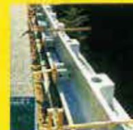
製品・型枠設置完了
