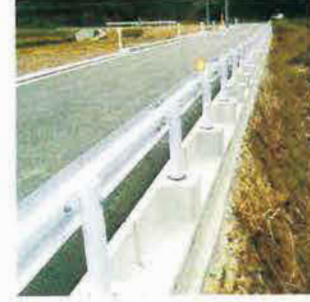
既設石積擁壁
