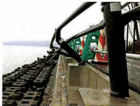
横方向から見た状況
