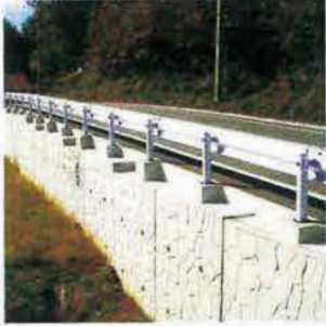
L型擁壁 (天端部分を外した例)
