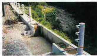
⑤ 製品を撤去した状況
