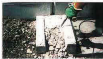
④ 間詰めコンクリート除去
