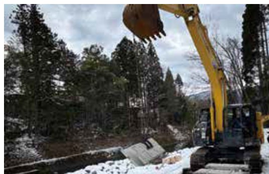
2. 専用治具でブロック本体を吊る
