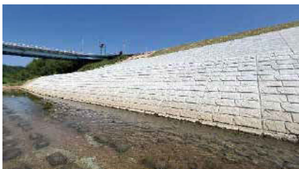
竣工後の様子 1
