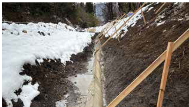
1. 基礎コンクリート打設
