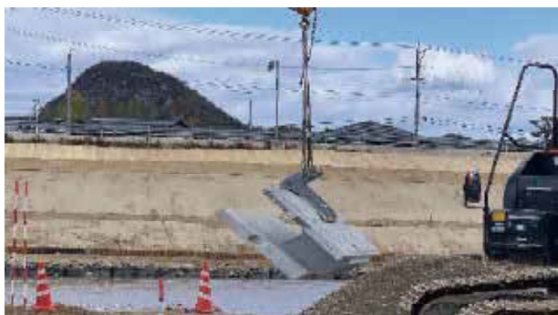
2. 専用治具でブロック本体を吊る
