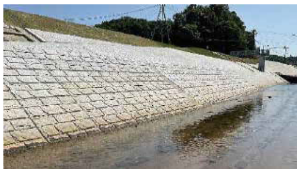
竣工後の様子 2
