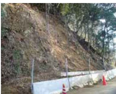
施工後：崩壊土砂を捕捉
