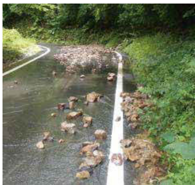
小規模落石の状況
