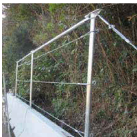
横ロープ設置完了
