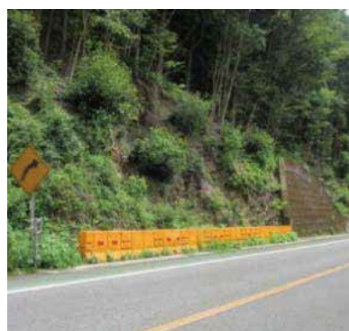
プラスチック防護柵 対処事例
