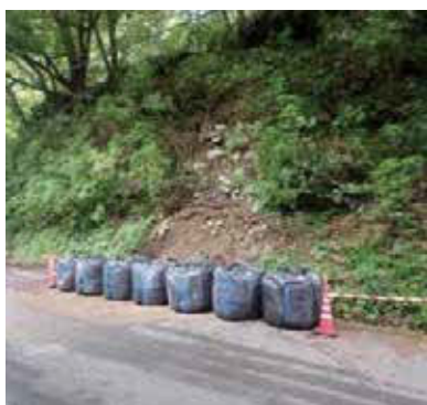
大型土のう対処事例
