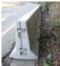
基礎擁壁の側面
