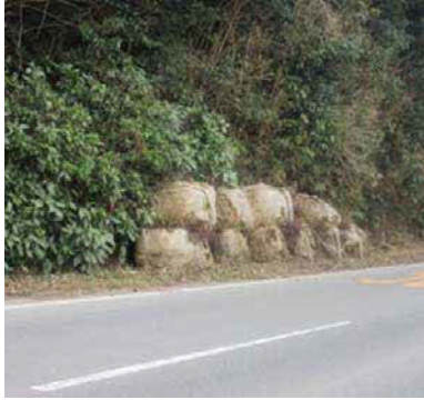
施工前：大型土のう
