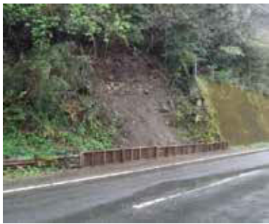
施工前：崩壊現場に仮設の木柵
