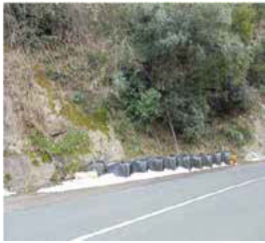
施工前：大型土のう
