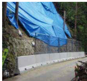
崩壊斜面下に仮設で設置
