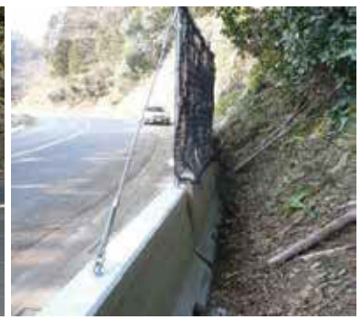
施工後：落石混じり土砂を捕捉
