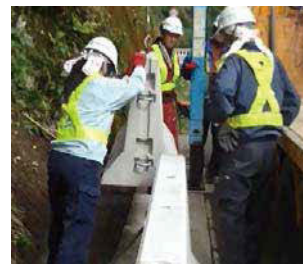
基礎擁壁の設置状況(2)
