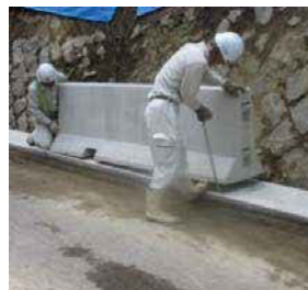
基礎擁壁の設置状況(1)
