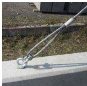
斜ロープと基礎擁壁を接続
