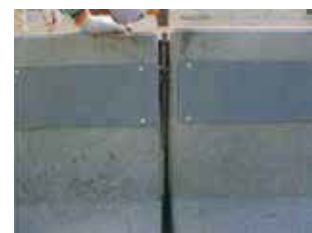
設置して連結筋が挿入された状況
