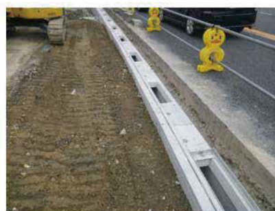
フラットな側面で埋め戻し転圧が容易
