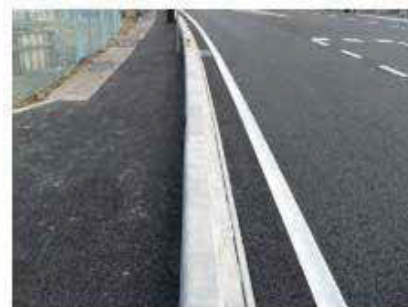
自転車走行時、滑りやすいコンクリート面は15cmと極小に。
