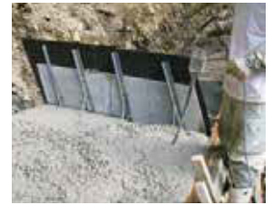
コンクリートの打設状況
