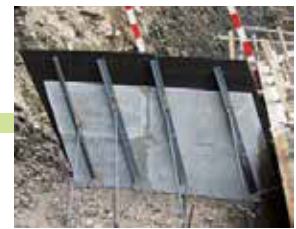
目地材を貼り付けて完了
