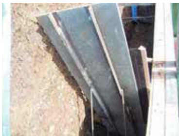
張コンクリート擁壁 その1
