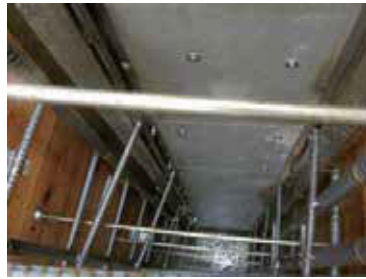
逆T型擁壁
