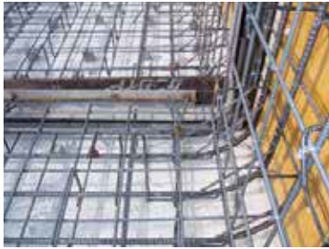
U型擁壁 (隅角部)
