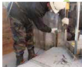
スレートボード位置を決定し、設置後に削孔(設置位置で組み立てた場合)
