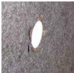
目地材側の設置した状況
