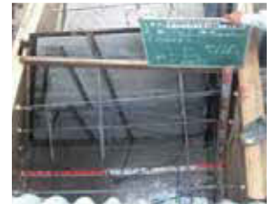
二段以降の設置が完了した状況
