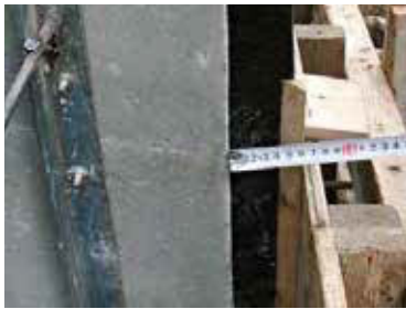
スレートボードを型枠から50mm引いた位置に設置した状況
