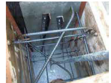
もたれ式擁壁（打設状況）
