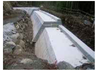
補強土壁の基礎が完成した状況
