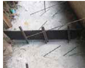
一段目の打設が完了
