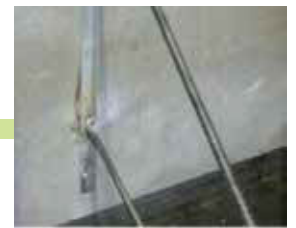
地面と接する最下段は、地面とアングル間は鉄筋かぶりを確保する
