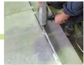
平地で縦バタ用鋼材の位置決め、スレートボードに削孔(平地で組み立てた場合)
