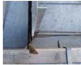
目地材固定状況
