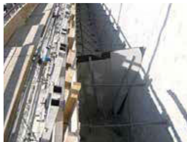
張コンクリート擁壁 その2
