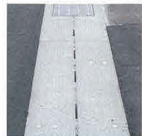
④施工完成
