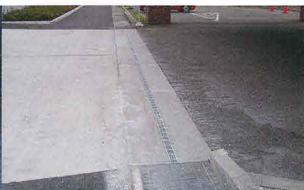
施工後（愛知県北名古屋市）
