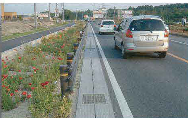
施工後（愛知県豊田市）
