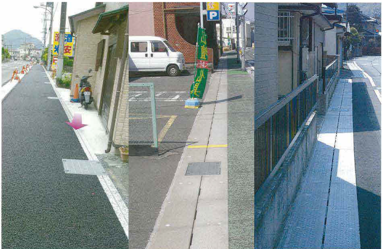
国道414号線 (静岡県下田市)
