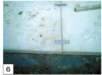
連結部は連結プレートにて連結する
