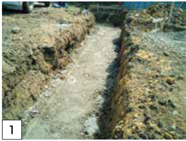
施工場所を掘削して碎石を敷く
