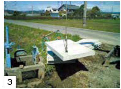
重機にて2点で吊り上げる
