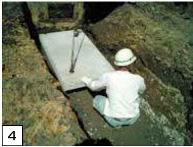
本体が2.0mのため1.5mのベースプレートを設置 横断側溝とベースプレートのジョイント部が同じ所にこないようにする
