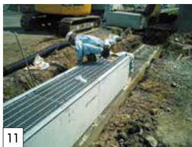
PU3型横断側溝500A×2,000 (ノンスリップ) T-25 連結状況
