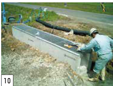
PU3型横断側溝500A×2,000 (ノンスリップ) T-25 連結状況
