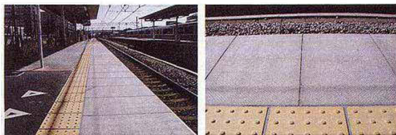
写真4 ノスキッド仕上げのプラットホームへの適用
