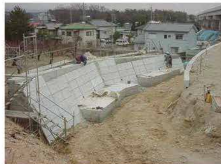
名四国道事務所 東海環状藤岡地区
