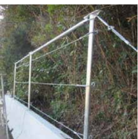
横ロープ設置完了
