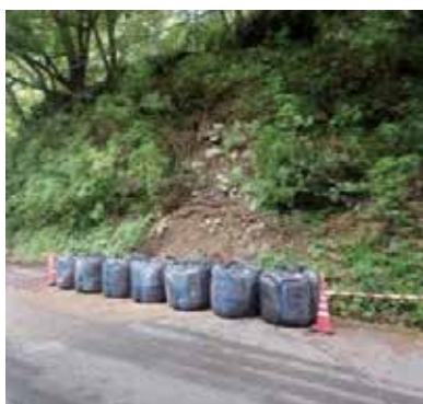
大型土のう対処事例
