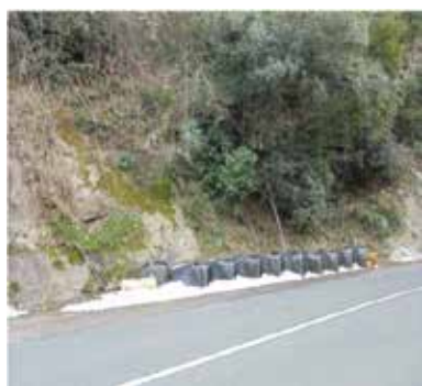
施工前：大型土のう
