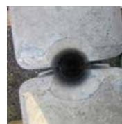
設置後に上から見た状態
