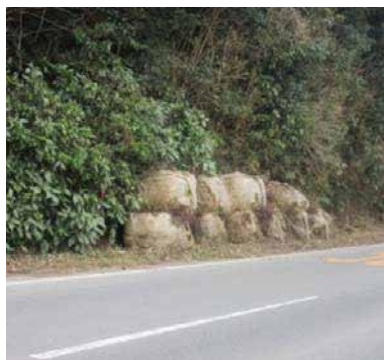
施工前：大型土のう
