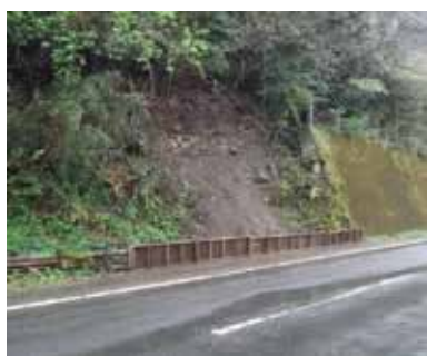
施工前：崩壊現場に仮設の木柵
