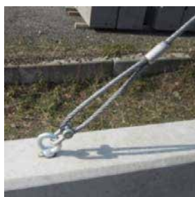
斜ロープと基礎擁壁を接続
