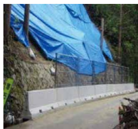
崩壊斜面下に仮設で設置
