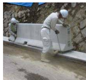
基礎擁壁の設置状況(1)
