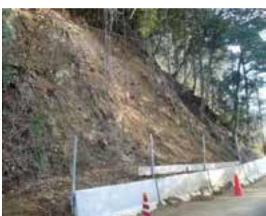
施工後：崩壊土砂を捕捉
