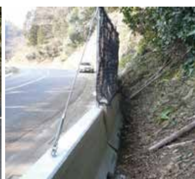
施工後：落石混じり土砂を捕捉
