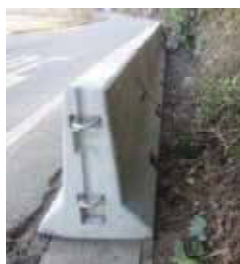
基礎擁壁の側面
