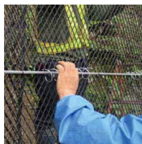
ネットジョイント設置
