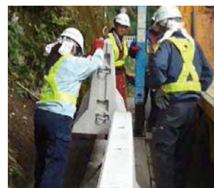
基礎擁壁の設置状況(2)
