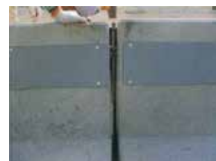
設置して連結筋が挿入された状況
