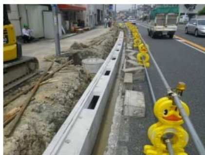
側面の形状は凹凸がなくシンプル
