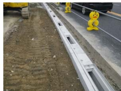
フラットな側面で埋め戻し転圧が容易
