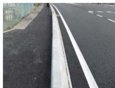
自転車走行時、滑りやすいコンクリート面は15cmと極小に。
