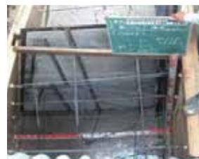
二段以降の設置が完了した状況
