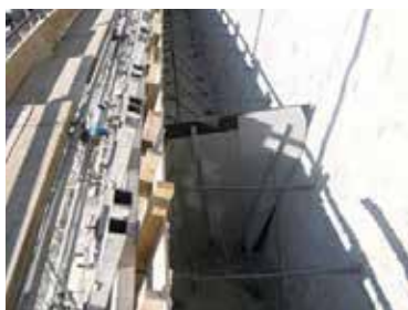
張コンクリート擁壁 その2
