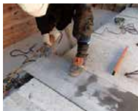
位置寸法に合わせて切断
