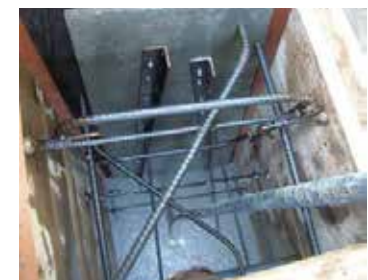
もたれ式擁壁（打設状況）
