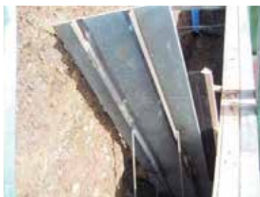
張コンクリート擁壁 その1
