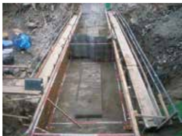
谷止工（2リフト）
