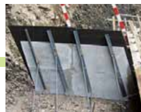
目地材を貼り付けて完了
