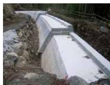
補強土壁の基礎が完成した状況
