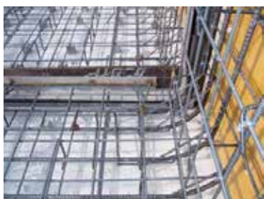
U型擁壁（隅角部）
