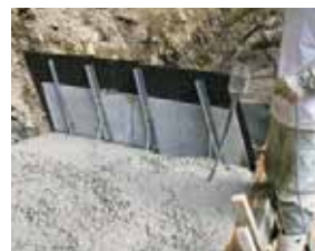
コンクリートの打設状況
