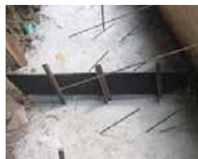
一段目の打設が完了
