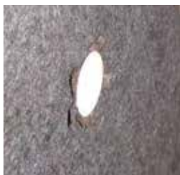
目地材側の設置した状況
