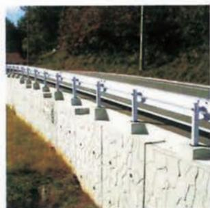
L型擁壁（天端部分を外した例）
