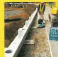
埋戻し、路盤工施工
