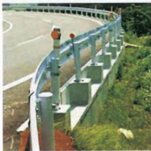
L型擁壁（天端前面に合わせた例）
