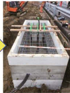
⑥打設前準備完了 (12:30終了)
