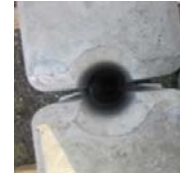
設置後に上から見た状態
