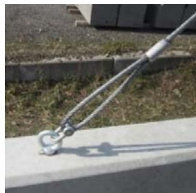
斜ロープと基礎擁壁を接続
