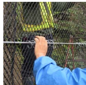
ネットジョイント設置
