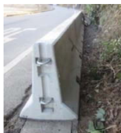
基礎擁壁の側面
