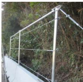
横ロープ設置完了
