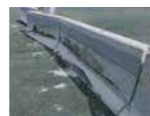
終点側から見た状況
