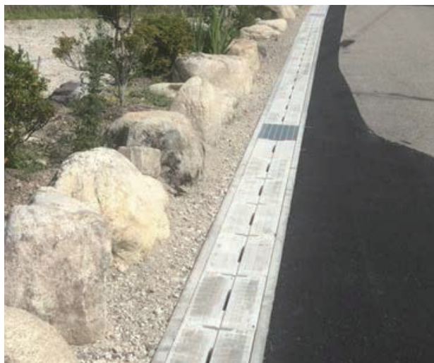
下呂市役所様 発注 FX側溝300x300=24m、蓋300用スリットタイプ
