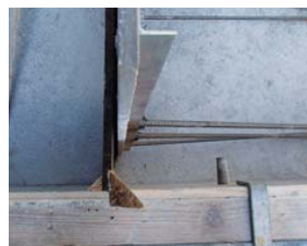
目地材端部固定状況
