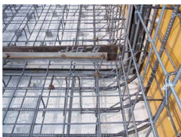
U型擁壁（隅角部）
