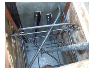
もたれ式擁壁（打設状況）
