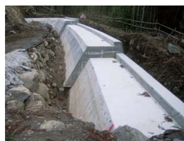
補強土壁の基礎が完成した状況
