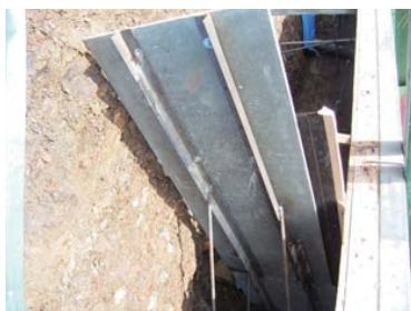
張コンクリート擁壁 その1
