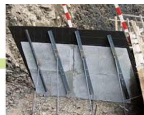
目地材を貼り付けて完了
