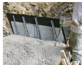
コンクリートの打設状況
