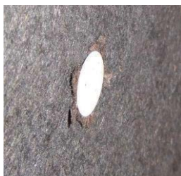
目地材側の設置した状況
