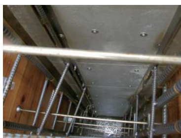
逆T型擁壁
