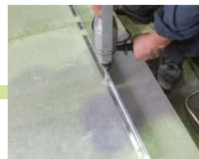
平地で縦バタ用鋼材の位置決め、 スレートボードに削孔(平地で組み立てた場合)
