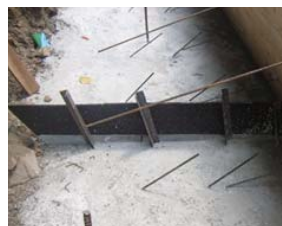
一段目の打設が完了
