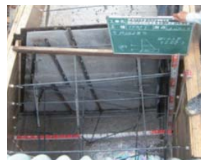
二段以降の設置が完了した状況
