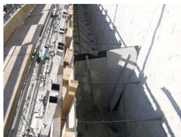
張コンクリート擁壁 その2
