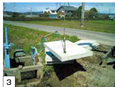
3 重機にて2点で吊り上げる
