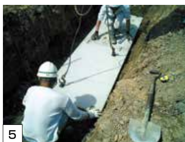
5 2枚目以降は2.0mのベースプレートを設置する
