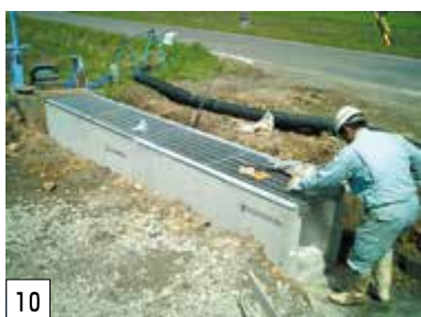
10 PU3型横断側溝500A×2,000 (ノンスリップ) T-25 連結状況
