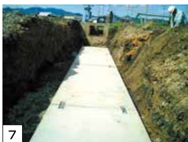
7 連結した状況①
