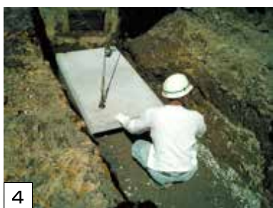
4 本体が2.0mのため1.5mのベースプレートを設置 横断側溝とベースプレートのジョイント部が同じ所にこないようにする
