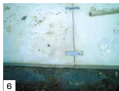
6 連結部は連結プレートにて連結する
