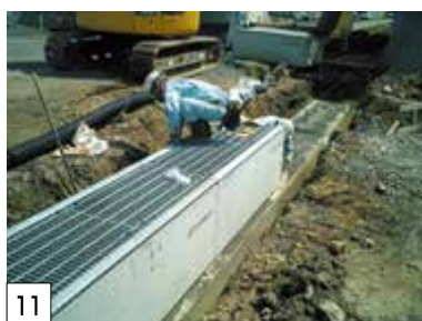
11 PU3型横断側溝500A×2,000 (ノンスリップ) T-25 連結状況
