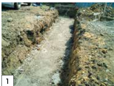
1 施工場所を掘削して碎石を敷く
