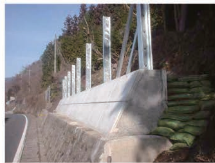
多治見砂防国道事務所 R19 中津川市山口
