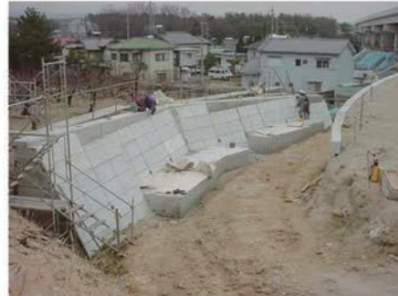
名四国道事務所 東海環状藤岡地区
