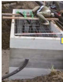
⑤アンカー ボルト組付け
