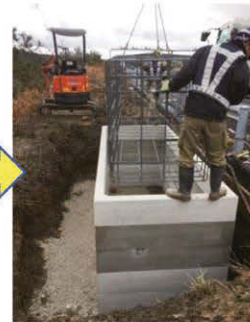
④鉄筋建て込み
