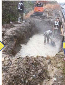
②砕石敷均し
