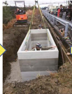
③基礎型枠据付
