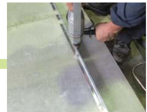
平地で縦バタ用鋼材の位置決め、スレートボードに削孔(平地で組み立てた場合)
