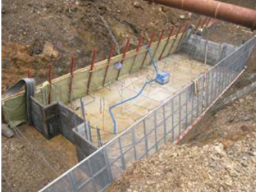
谷止工 (1リフト)
