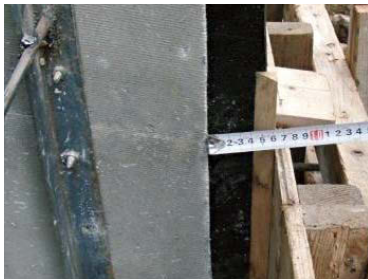
スレートボードを型枠から50mm引いた位置に設置した状況
