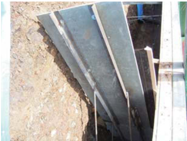
張コンクリート擁壁 その1
