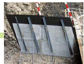
目地材を貼り付けて完了
