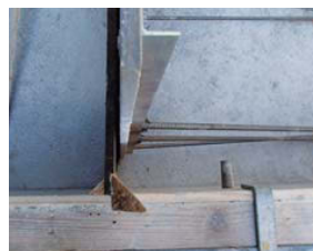
目地材固定状況
