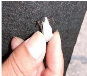
先端を閉じ目地材側から押し込みます
