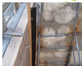
アングル間を鉄筋で結合補強した例
