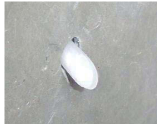
スレートボード側に押し込んだ状況
