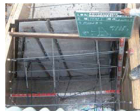
二段以降の設置が完了した状況
