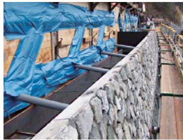
化粧型枠の内側に目地材を設置した状況
