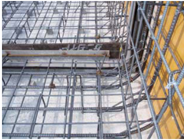
U型擁壁 (隅角部)
