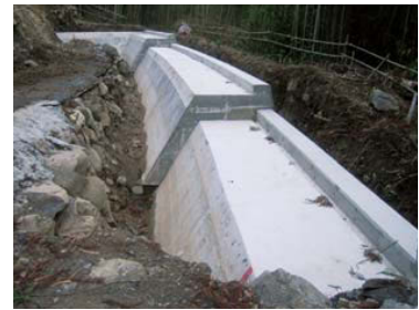
補強土壁の基礎が完成した状況
