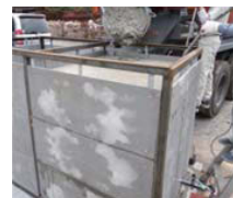
コンクリートの打設状況
