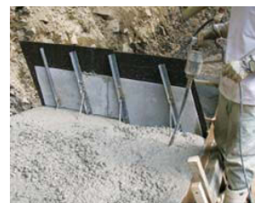
コンクリートの打設状況
