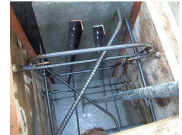
もたれ式擁壁 (打設状況)
