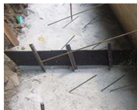
一段目の打設が完了
