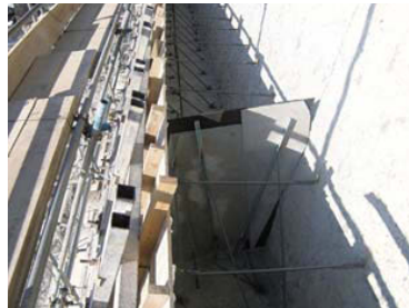
張コンクリート擁壁 その2
