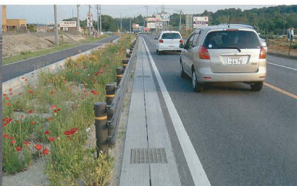
施工後（愛知県豊田市）
