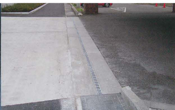
施工後（愛知県北名古屋市）
