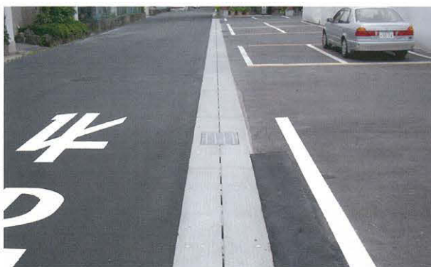
施工後 市道 31346 号線補修工事（静岡県伊豆市）
