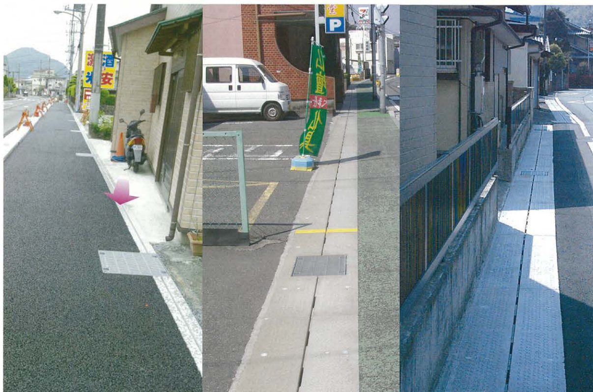
国道 414 号線 (静岡県下田市)
