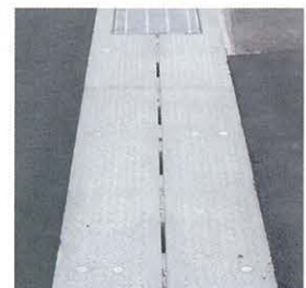
④施工完成
