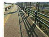
補修した後の全景
