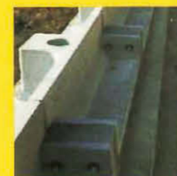
間詰めコンクリート完了
