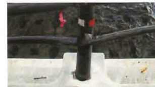
横断方から見た状況
