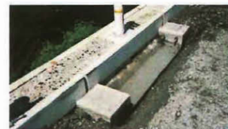
③底版上の土を取り除いた状況
