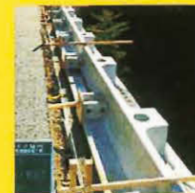
製品・型枠設置完了
