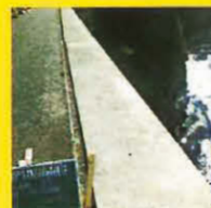
均しコンクリート
