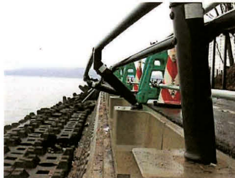
横方向から見た状況
