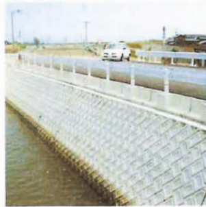
間知ブロック積擁壁
