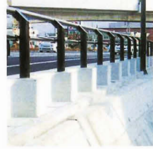
大型ブロック積擁壁
