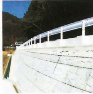
大型ブロック積擁壁
