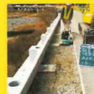
埋戻し、路盤工施工
