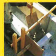
コンクリート打設状況
