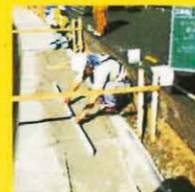
敷きモルタル
