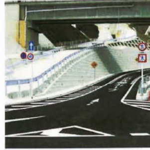
間知ブロック積擁壁
