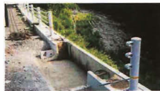
⑤製品を撤去した状況
