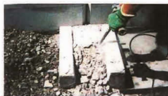
④間詰めコンクリート除去
