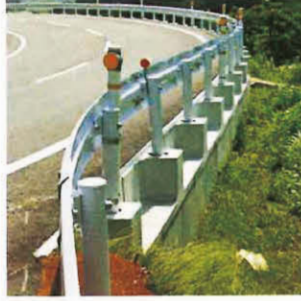
L型擁壁 (天幅前面に合わせた例)
