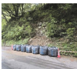
大型土のう対処事例
