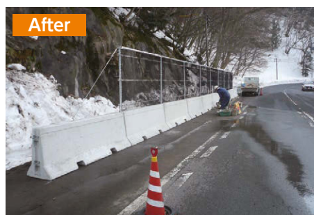
基礎擁壁に防護柵をセットした状況
