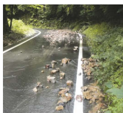
小規模な落石・崩壊の状況
