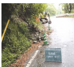
小規模な落石・崩壊の状況
