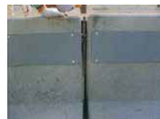
設置して連結筋が挿入された状況
