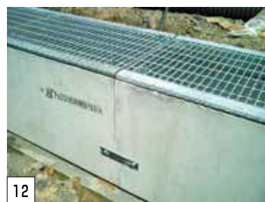
PU3型横断側溝500A×2,000(ノンスリップ)T-25 プレートにて連結
