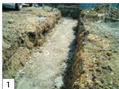
施工場所を掘削して砕石を敷く
