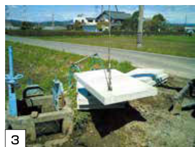
重機にて2点で吊り上げる
