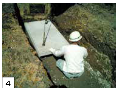
本体が2.0mのため1.5mのベースプレートを設置 横断側溝とベースプレートのジョイント部が同じ所にこないようにする
