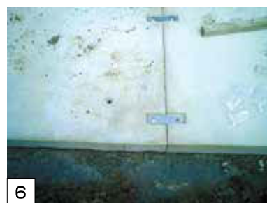
連結部は連結プレートにて連結する
