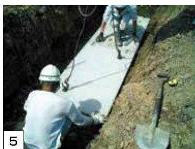
2枚目以降は2.0mのベースプレートを設置する 横断側溝とベースプレートのジョイント部が同じ所にこないようにする
